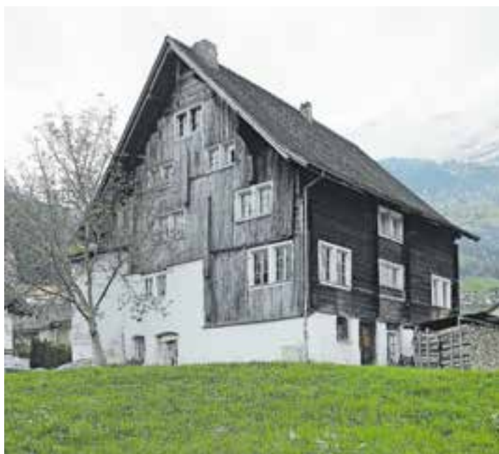
Das Haus Unter Hof ist als einziges steilgiebeliges Haus der repräsentativen historischen Profanbau der Gemeinde Schattdorf. Bild: PD
