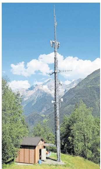
Die im September 2017 umgebaute Mobilfunkanlage «unter Axeli» in Gurtellen. Bild: PD
