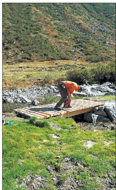
Ein Zivilschützer beim Fertigstellen einer Brücke an der Via Gottardo.
